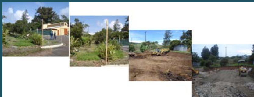
Fotos secuenciales del arreglo de terrenos para inicio de la Construcción
