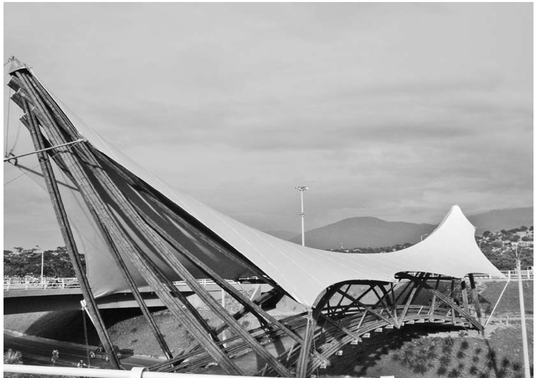
Figura N.º 11. Puente en Cúcuta, Colombia. Detalle de las tirantas, Jörg Stamm.
