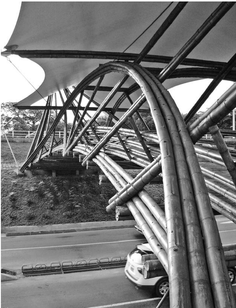
Figura N.º 9. Arco compuesto por 6 guaduas. Jörg Stamm.
