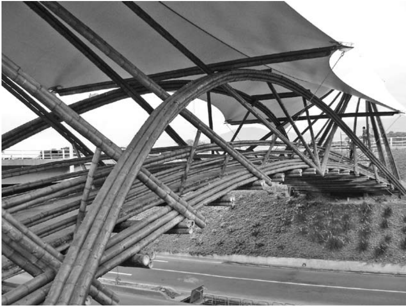
Figura N.º 10. Arco de carga y arco del barandal. Puente en Cúcuta, Jörg Stamm.
