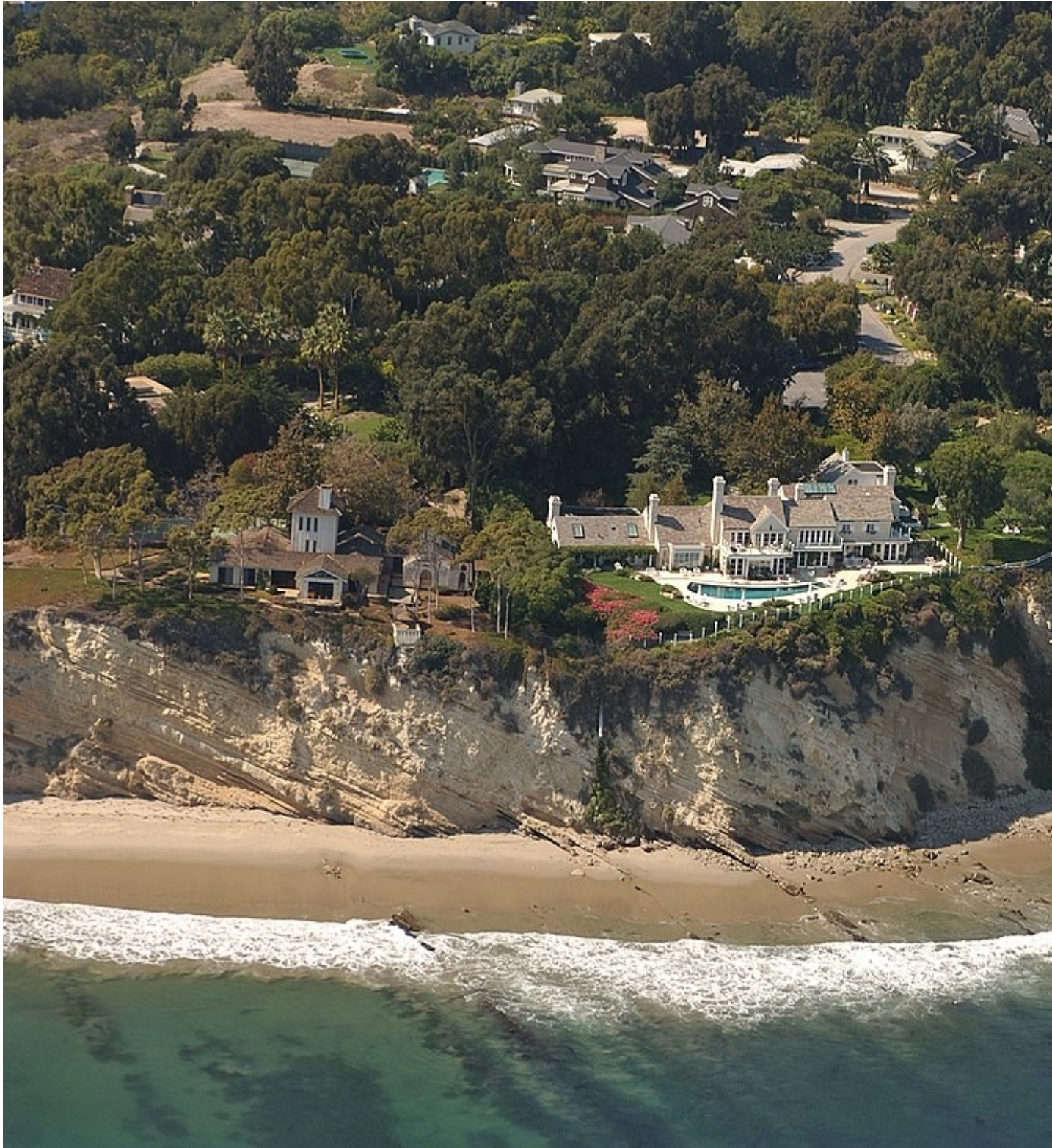
Imagen de la erosión de la costa californiana. Al fondo la casa de Barbra Streisand. (Kenneth & Gabrielle Adelman, 2002).
