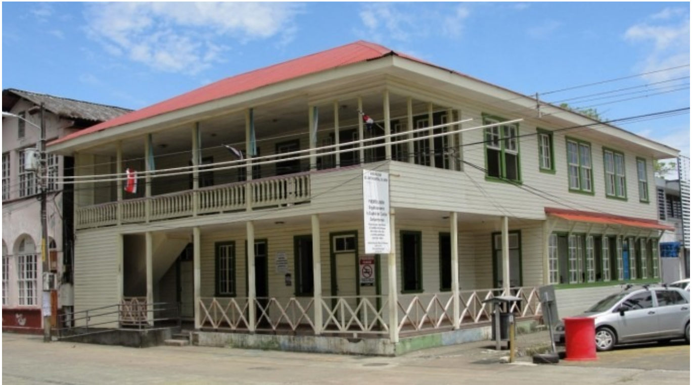
La antigua Capitanía de Puerto Limón es uno de los pocos inmuebles de arquitectura caribeña costarricense de dos plantas que aún se mantienen en pie. Actualmente, lo ocupa el Centro Comunitario de Expresión Artística de la Municipalidad de Limón. Foto cortesía de Kenia García.
