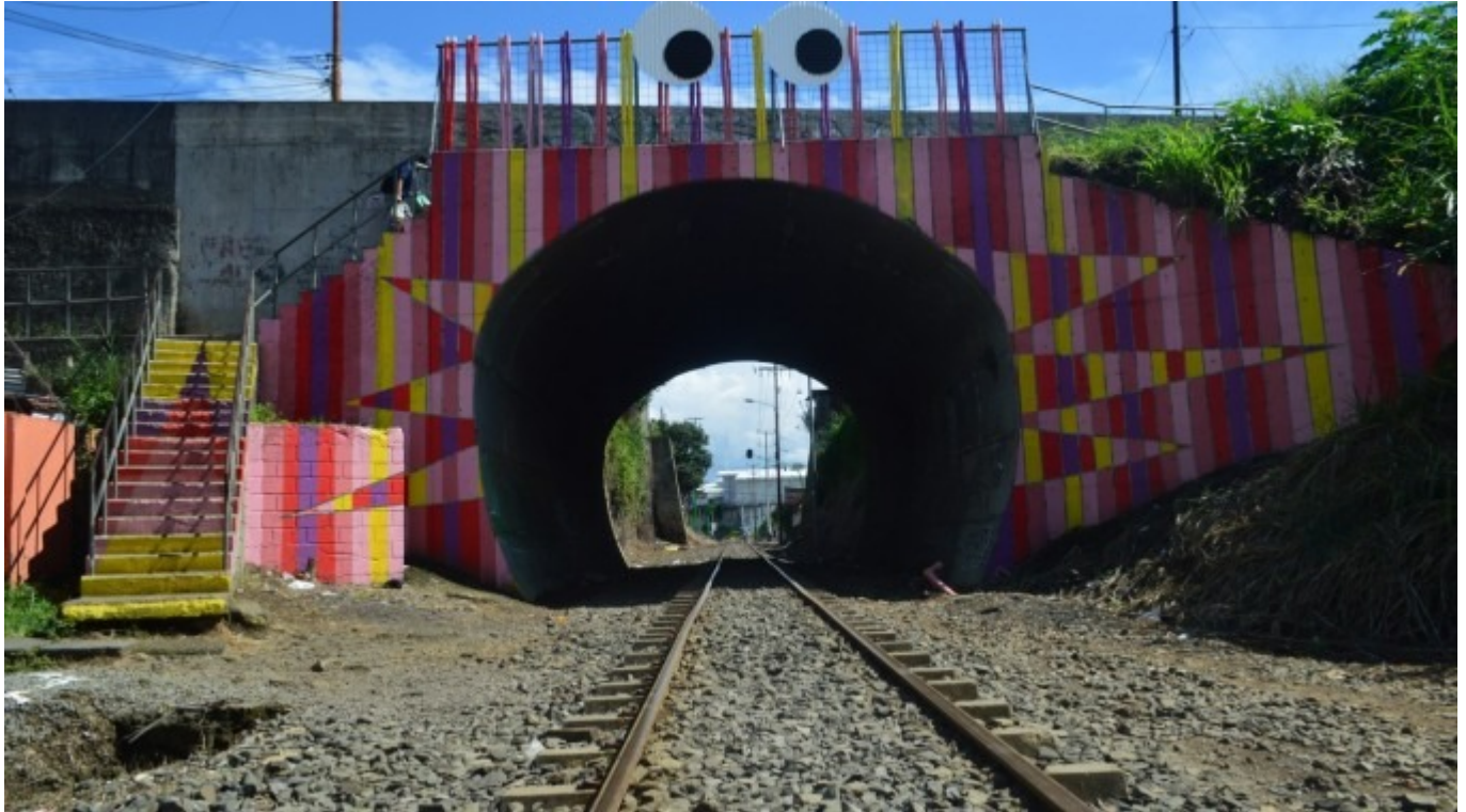
El túnel del ferrocarril entre Barrio Aranjuez y San Francisco de Goicoechea se convirtió en un colorido personaje. Foto: Fernando Montero, OCM.
