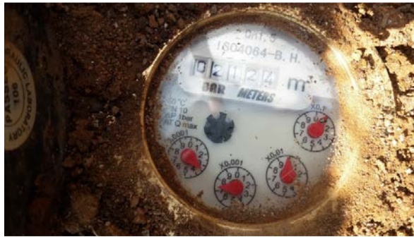
Figura 3 Lectura del medidor de agua. 16 de febrero 2017.
