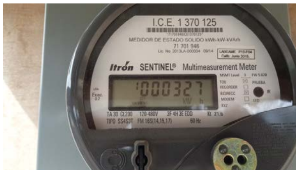
Figura 5 Lectura del medidor de electricidad (trifásica). 16 de febrero 2017.
