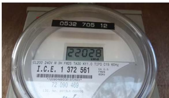
Figura 4 Lectura del medidor de electricidad (monofásica). 16 de febrero 2017.
