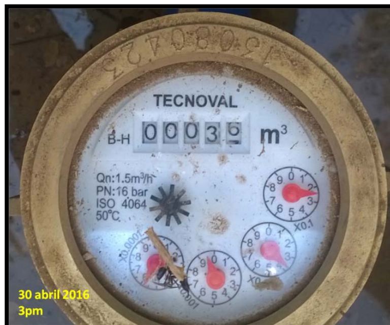
Figura 2. Medidor de agua 2.
