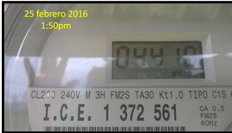
Figura 3. Medidor de energía eléctrica.
