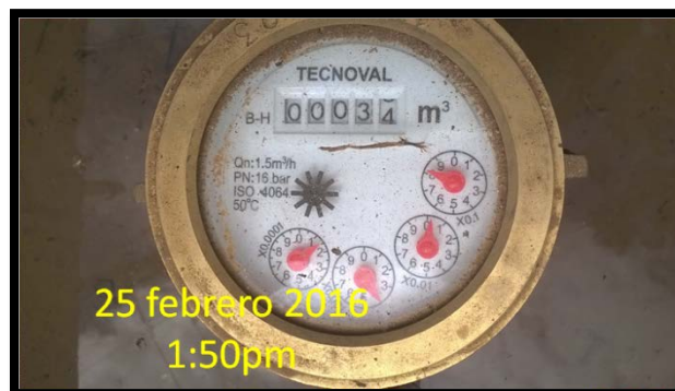
Figura 2. Medidor de agua 2.
