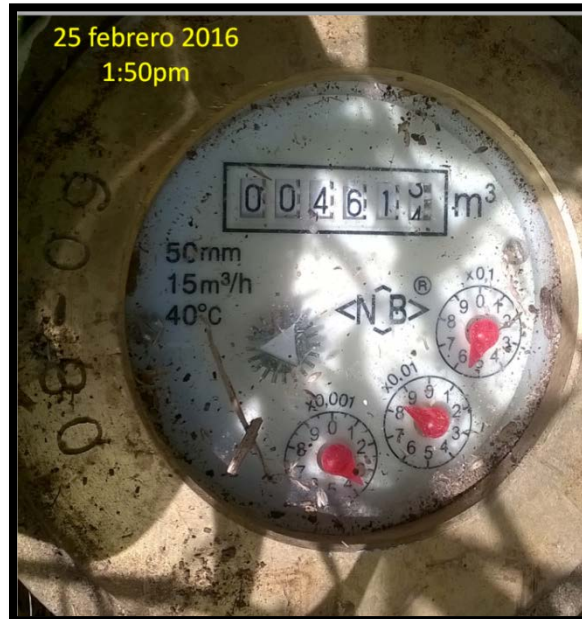
Figura 1. Medidor de agua 1.
