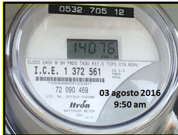
Figura 2. Medidor de energía eléctrica.
