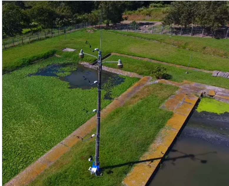
Figura 1. Torre meteorológica en la planta de tratamiento 1 .
