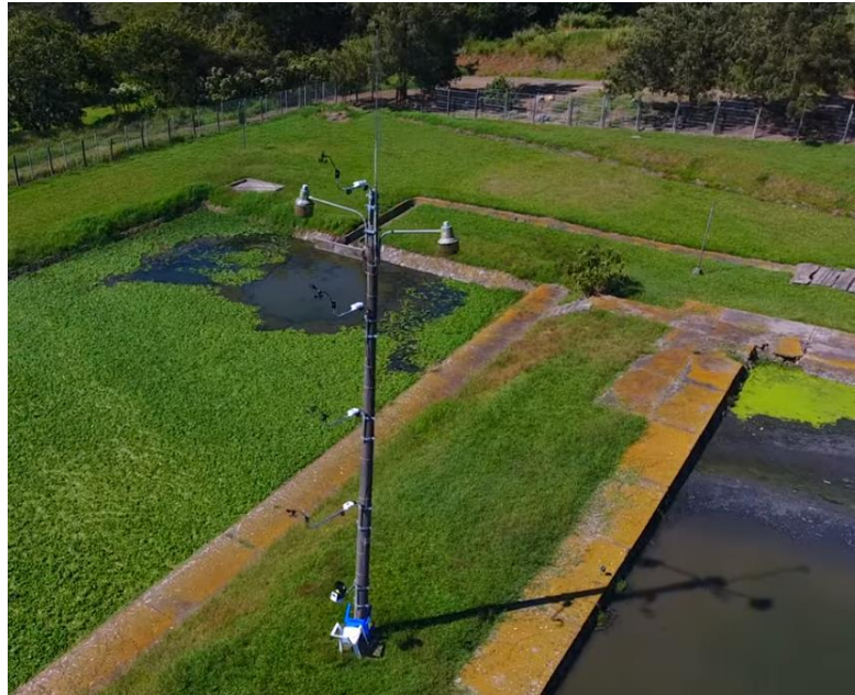
Figura 1. Torre meteorológica en la planta de tratamiento 1 .
