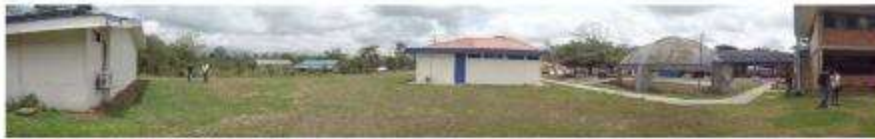
Foto 4. Sitio del proyecto donde se va desarrollar el edificio de aulas, los alrededores se presentan intervenidos por los edificios del campus existente, se observa la topografía plana del lugar.
