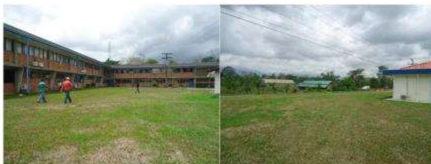
Foto 1. Vista de unos de los sectores donde se proyectan nuevas obras (Edificio para Aulas), dentro del campus existente.
