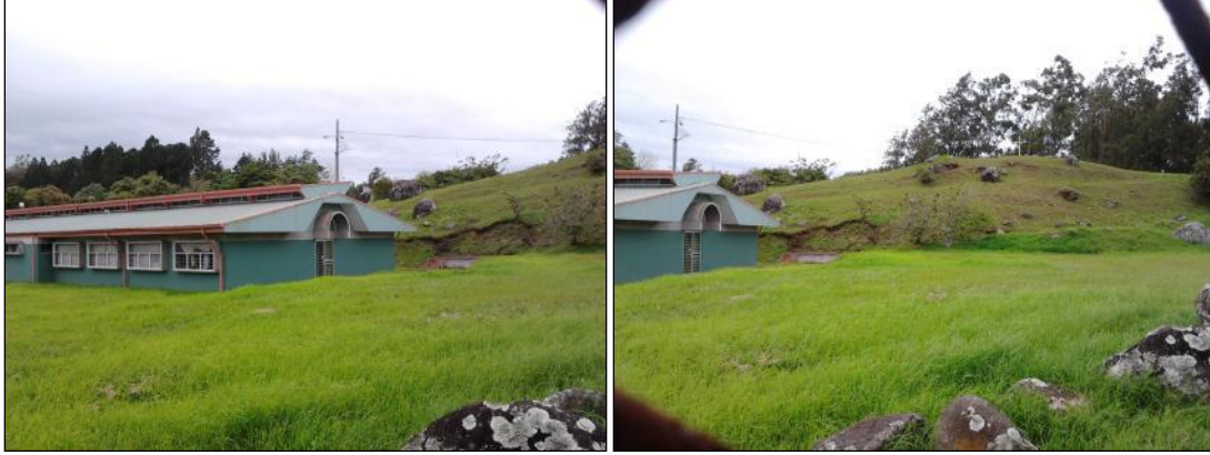
Fotografías Nº 4 y 5: Área del proyecto. (Edificio sobre el sector norte del Campus ITCR).
