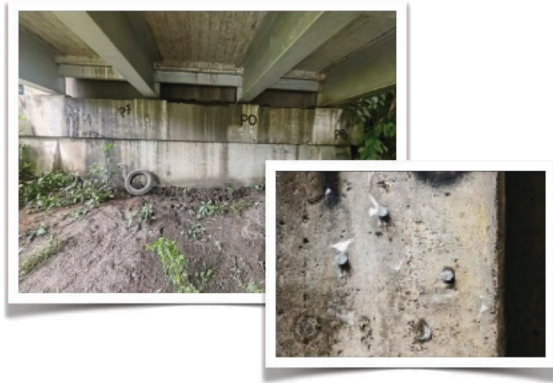
Inspección puente y análisis de materiales estructura - La Cruz Guanacaste
