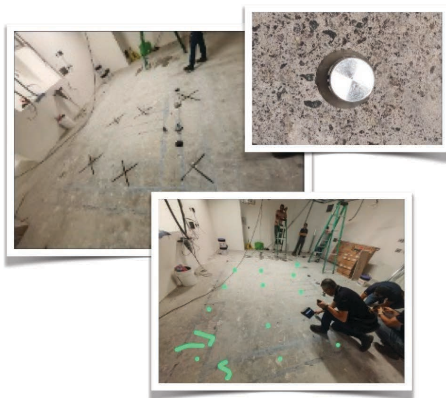
Inspección piso - Clínica Bíblica San José
