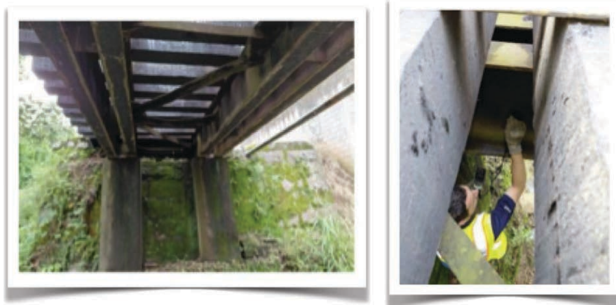
Evaluación de puentes ferroviarios
