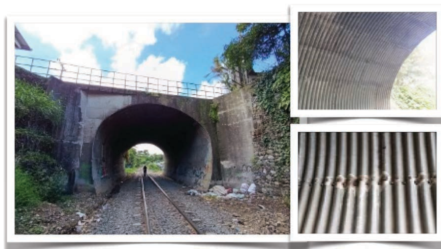
Inspección Galvanizado - El Roble de Puntarenas
